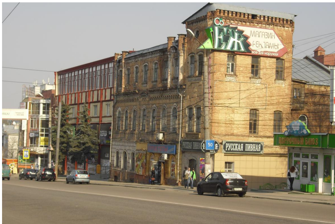
Дом дворянина В.В. Толубеева (ул. Дзержинского 62), где располагалось Управление трамвая с 1898 по 1912 год.
