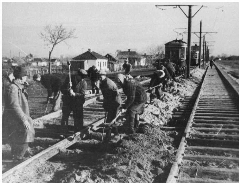
Ремонт пути на ул. Литовской
