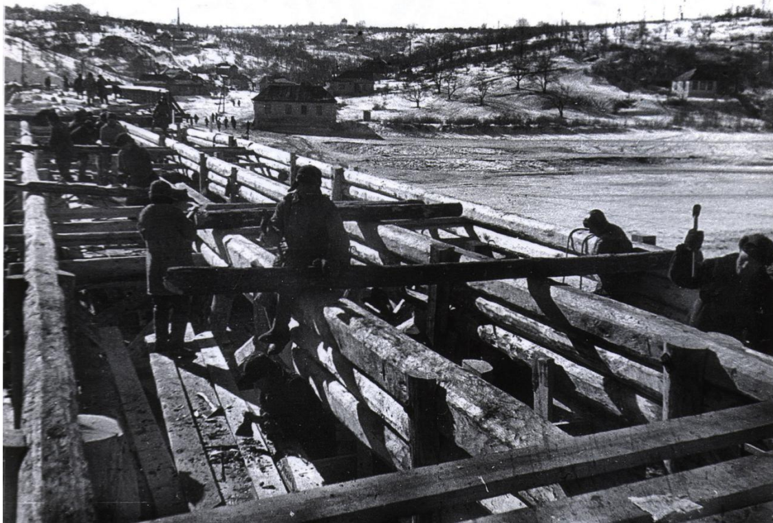
1943 г. Восстановление Кировского моста. Фото Олега Сизова.
