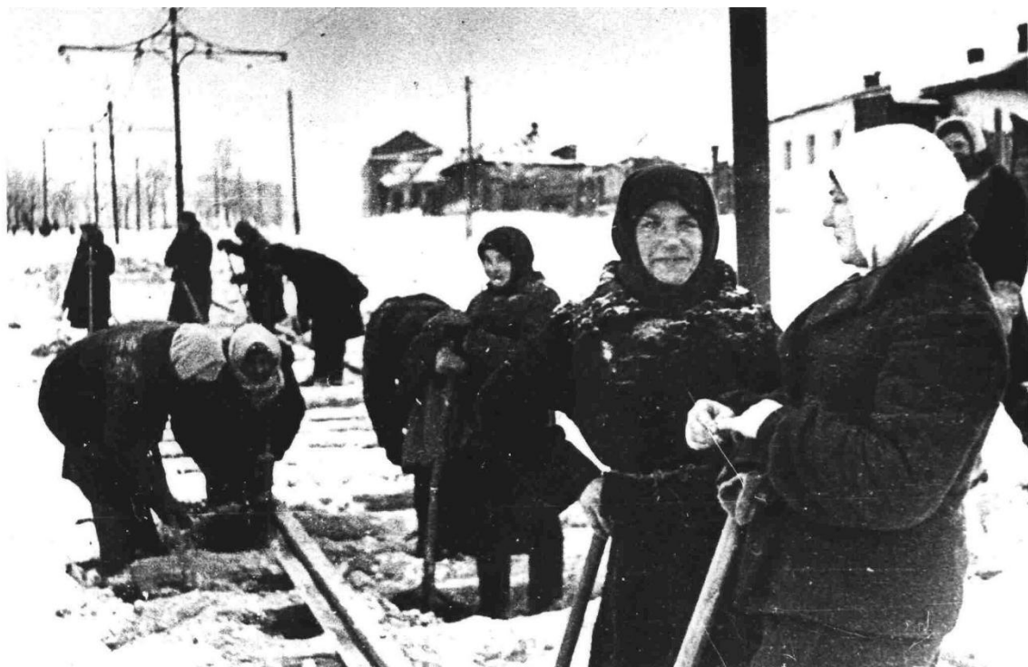
Домохозяйки трудятся на восстановлении линии в Ямскую.
