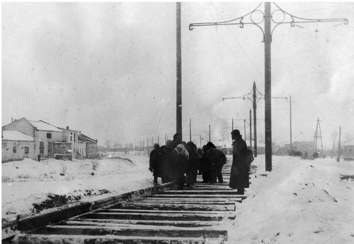
1944 год, добровольно-строительная бригада восстанавливает трамвайный путь на ул. 1-й Кожевенной
