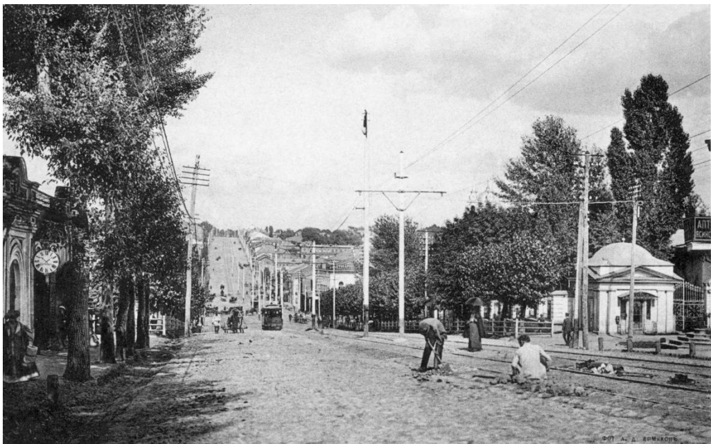
Путейские рабочие Курского трамвая за ремонтом пути на ул. Херсонской.
