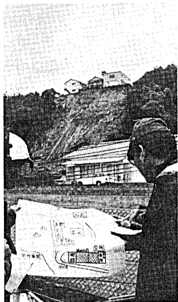
宇宿町の土砂くずれ現場
