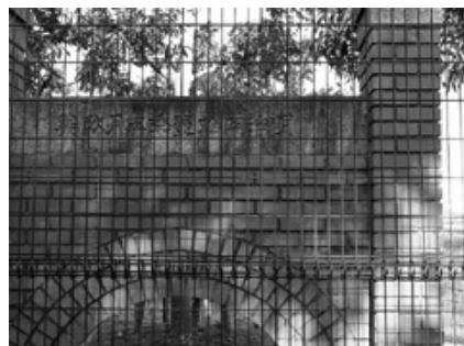
写真13 徳大寺樋門の遺構
