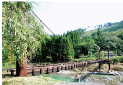
写真13 魚ヶ淵の吊り橋
