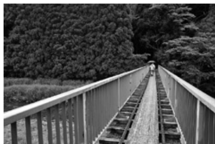
写真17 由良川橋(トロッコ道)
