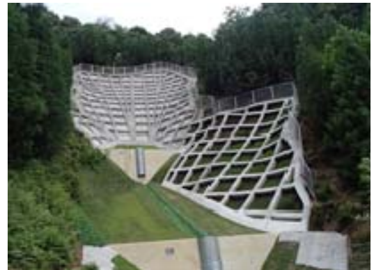
広島市安佐北区可部町桐原 (H26.8 豪雨災害 復旧状況)
