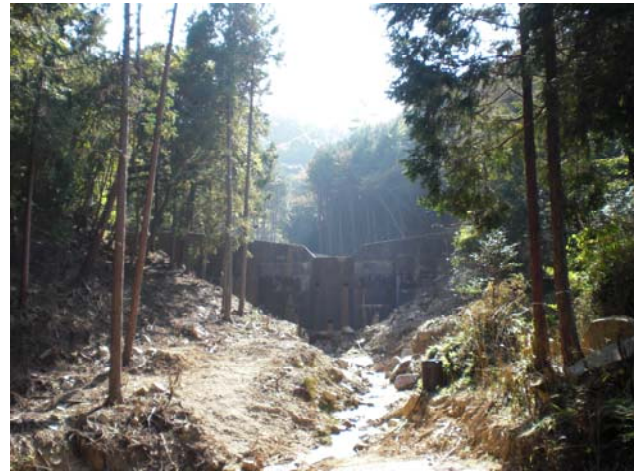
土砂災害を食い止めた既設谷止工
