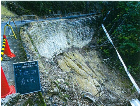
平成26年に被災した広島市安佐北区福王寺線の状況(左)及び復旧状況(右)。 林道法面上部で発生した山腹崩壊により、路肩及びガードレール等が損傷した。大型ブロックにより復旧を行った。
