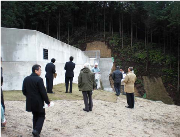
既設谷止工のコンクリート嵩上げ
