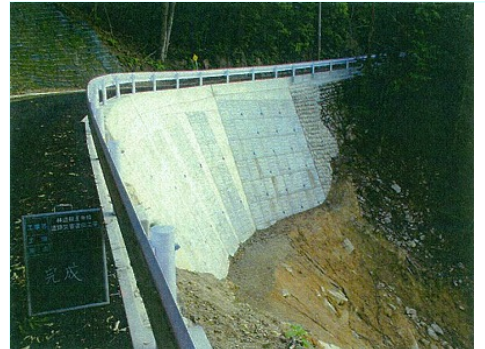
平成26年に被災した広島市安佐北区福王寺線の状況(左)及び復旧状況(右)。 林道法面上部で発生した山腹崩壊により、路肩及びガードレール等が損傷した。大型ブロックにより復旧を行った。
