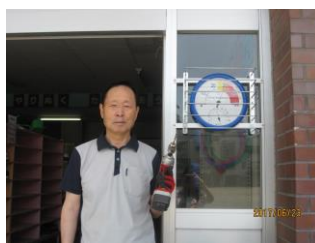
H29. 6. 23 昇降口へ熱中症予防対策 温湿度計取付作業
