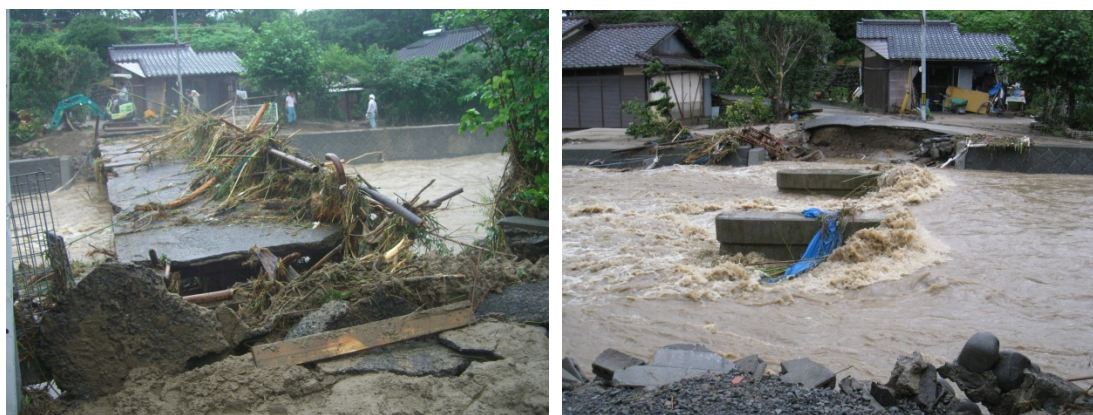
図 6.10 橋脚に漂流物がトラップされたことによる水位堰上げ（赤谷川 東林田地区）
