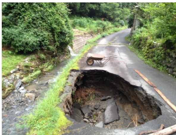
図 6.15 コンクリート護岸の被災例（左：護岸が転倒し河道内に留まることにより二次的な被害が生じている。右：護岸裏の土砂の吸出し）
