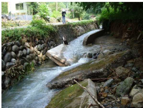
図 6.15 コンクリート護岸の被災例（左：護岸が転倒し河道内に留まることにより二次的な被害が生じている。右：護岸裏の土砂の吸出し）
