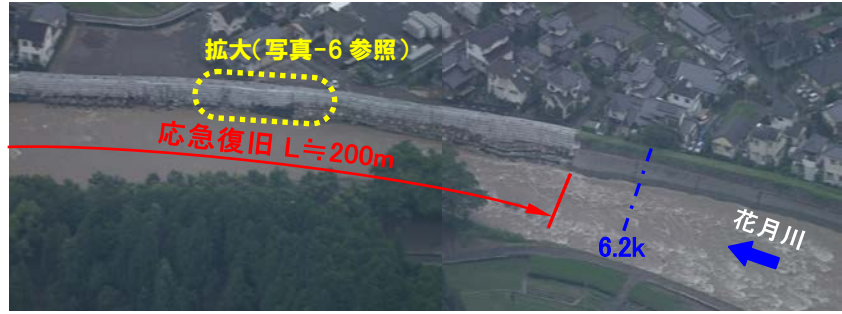
写真6.8* 応急復旧区間の出水時状況
