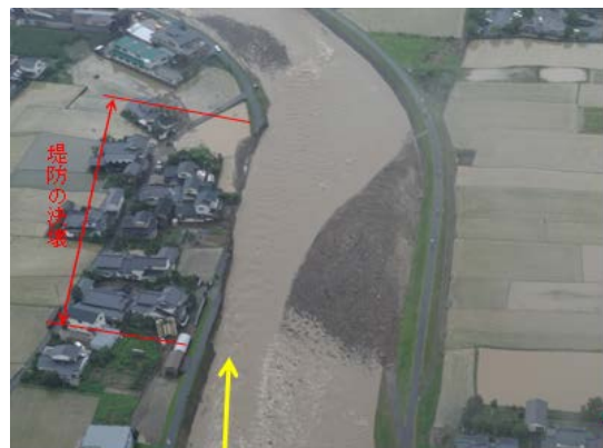
写真6.3 決壊箇所 5.8k左岸の対岸の土砂堆積
