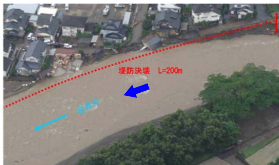
写真6.1 決壊状況 (筑後川河川事務所)
