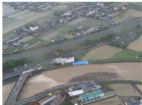
写真6.4 護岸崩壊箇所 5.6k右岸の対岸の土砂堆積
