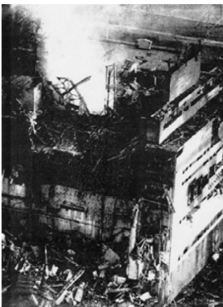
図3. 破壊され蒸気を噴き出す4号炉.
