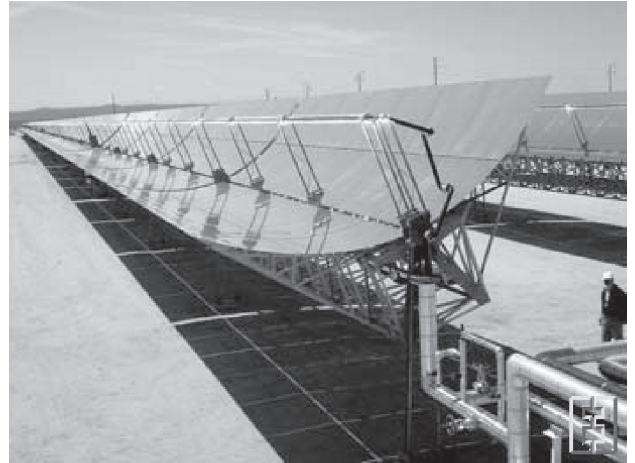
Fig. 16 トラフ式太陽熱発電システム 22)
