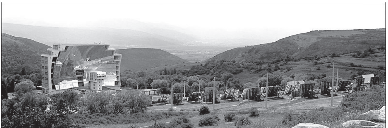
Fig. 6 フランス国立太陽エネルギー研究所のヘリオスタット型太陽炉 7)
