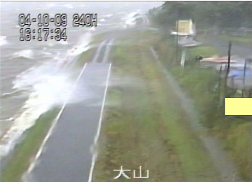
△H16.10.9 台風22号による波浪状況 (当施設より上流の箇所)
