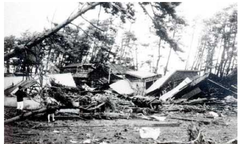
越波により被災した家屋 (富士海岸吉原地区)
