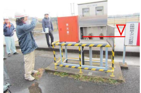
給油口の高さの確認
