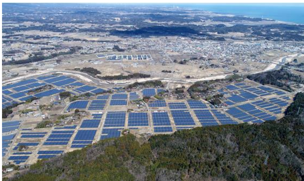
浪江酒井第一・第二太陽光発電所
