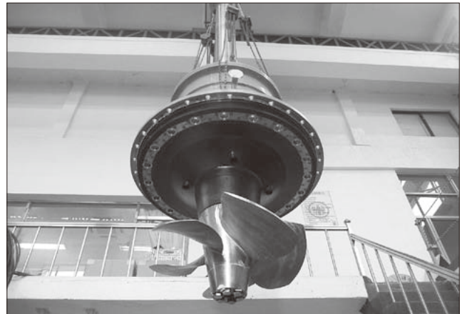
図 53 1.4MW立軸プロペラ水車用ランナ (据付け中)
