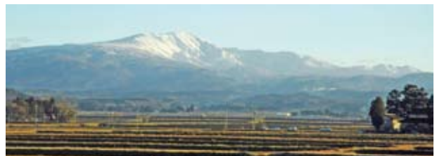
図-20 山体崩壊崖を見せる庄内側の月山
