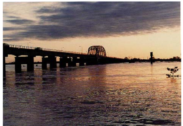
写真 4-8 治水橋（さいたま市）
