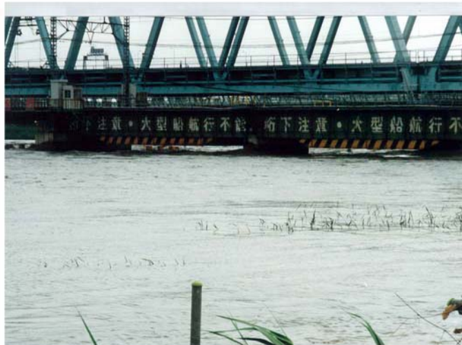
写真 4-12 形成押上線橋梁の洪水写真
