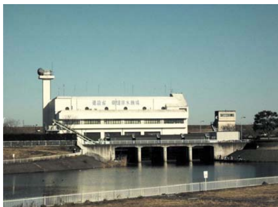
写真 4-13 南畑排水機場
