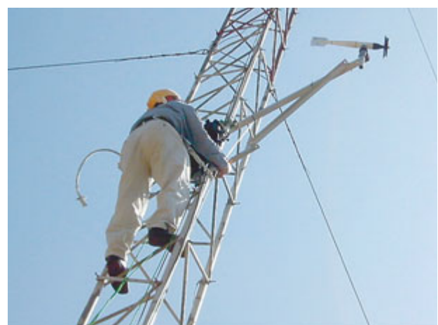
自動気象観測装置の取り付け
