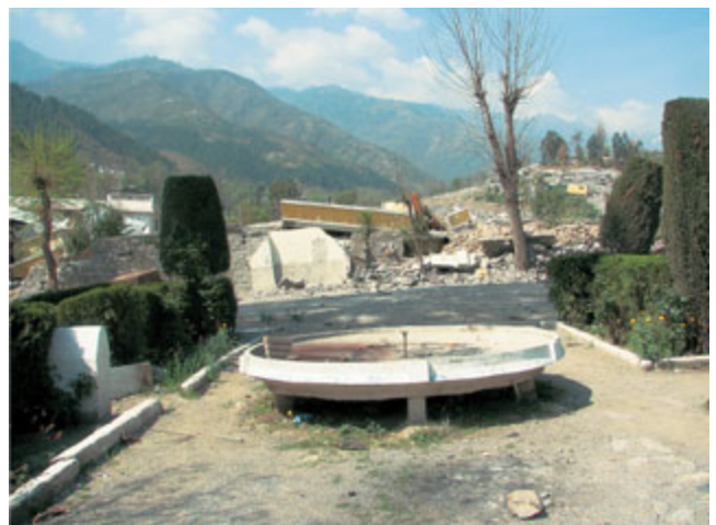
図4 バラコットの地震断層直上の被災状況。左は全景で、中央の左に傾斜する丘の上にあった中心街は全滅した。その左裾を右奥から左手前に地震断層が通過している。右はこの丘陵を手前から見たところで、写真中央奥から左手前に地震断層が通過している。地震断層の出現に伴って手前の噴水盤は左に約4度傾斜した。
