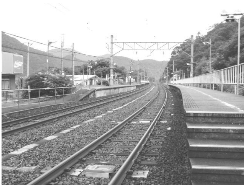
奥新川駅西端から仙台方向を見る
