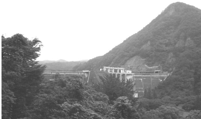
図4-2：大倉ダム堤体
