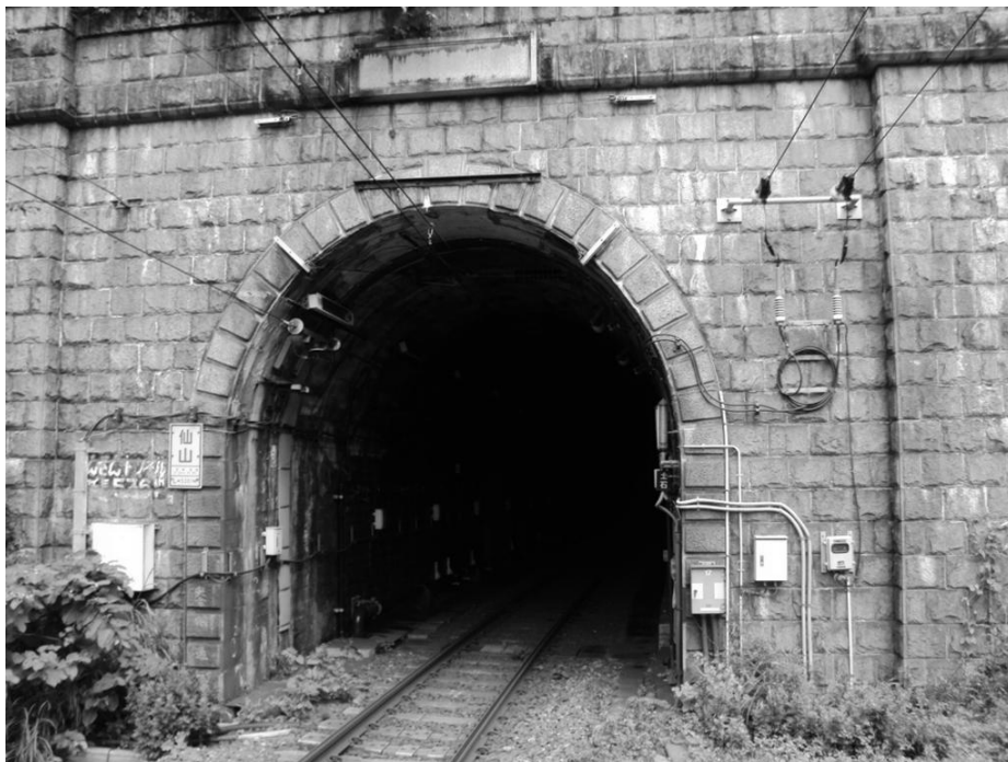
図6：仙山トンネル山形側坑口
