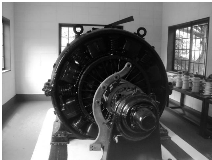
図4-15：変電所跡の横にある小屋の内部
