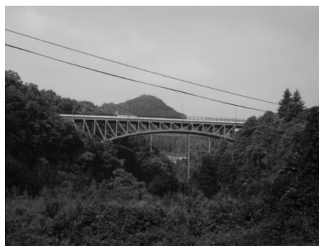
図3-4：熊ヶ根橋(道路橋)
