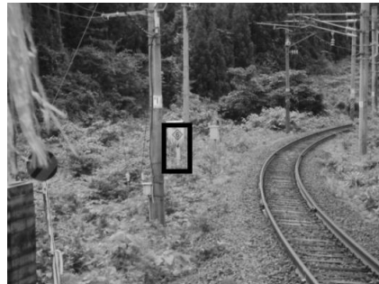
図3：八ツ森駅山形側の6両編成用停止位置目標(黒枠で囲んだ部分)
