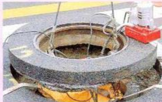
⑤ 吊り上げ撤去
