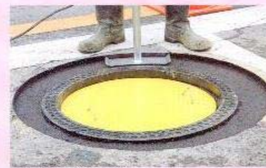
⑨ 円弧転圧機によるESモルタル打設
