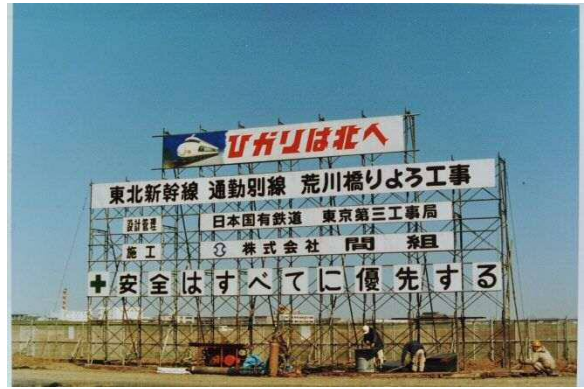
【写真 16】東北新幹線荒川橋梁建設工事 《1980年 鈴木和司氏撮影》
