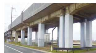
高架橋柱耐震補強
