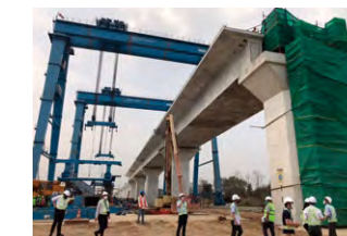
高架橋の建設現場
