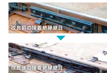
改良後の接着絶縁継目
