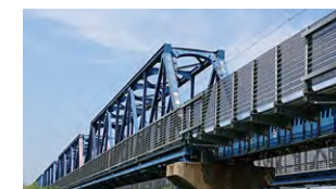
羽越本線 北余目～砂越間
