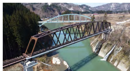
只見線復旧工事状況(第7只見川橋りょう)
