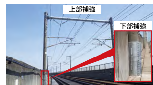
電柱耐震補強
