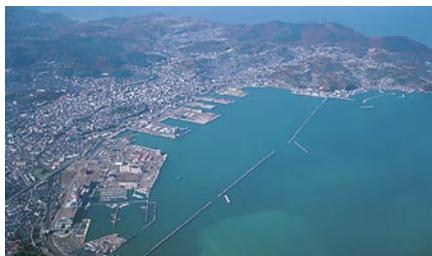
「港湾工学の父」広井勇により建設された北防波堤は、セイロン（現スリランカ）のコロンボ港防波堤を参考にし、独特の傾斜ブロック工法を採用した日本初の長大堤防。ケーソン法を取り入れた南防波堤とともに、今も現役で機能する。防波堤に守られた小樽みなとは北海道移住の玄関口となり、また物流拠点、貿易港として、商都・小樽の繁栄を支えた。
