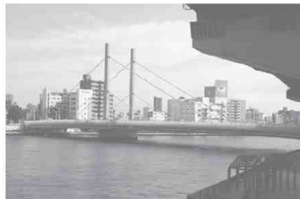
▲首都高6号線高架下からの新大橋
