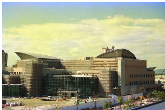
(建設工事中の福岡市総合図書館 写真資料 114-1-1)
