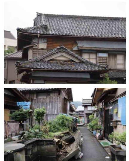
写真-1 被害の状況（上：外壁の剥落、下：ブロック塀の転倒、柴山，2019 2) ）
