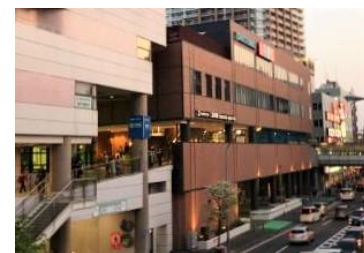
リニューアル工事が進む二俣川駅
