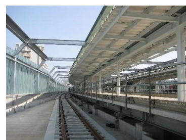
星川駅上り線高架ホーム（工事中）
