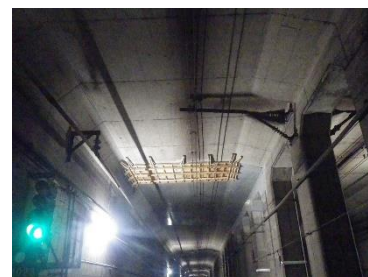
万騎が原トンネルの内部の様子
