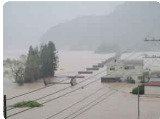
平成23年台風第12号 和歌山県新宮市日足能城方面の被災現場
