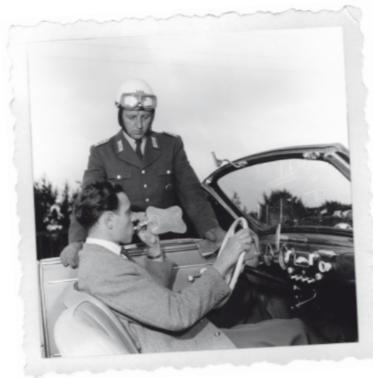
Der ›Alcotest‹ im Einsatz: Der Autofahrer pustet in ein Röhrchen, bis der Beutel mit Atemluft gefüllt ist. Anhand der Skala erkennt der Polizist auf einen Blick, ob der zulässige Grenzwert überschritten ist.
