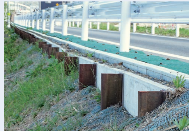
撤去した古レールを再利用した土留め
