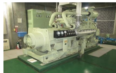
固定式自家発電機の整備
