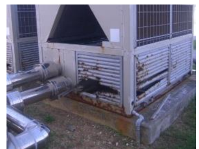
空調設備の更新
