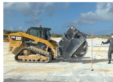
滑走路被害復旧器材
