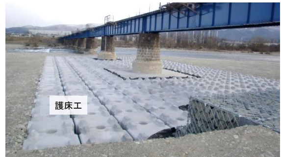
只見線 西若松駅～会津本郷駅間 （護床工※ 4 新設、2015 年度施工）
