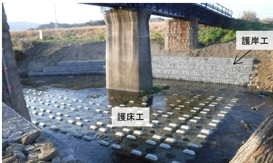
磐越東線 いわき駅～赤井駅間 （護床工・護岸工※ 4 新設、2019 年度施工）
