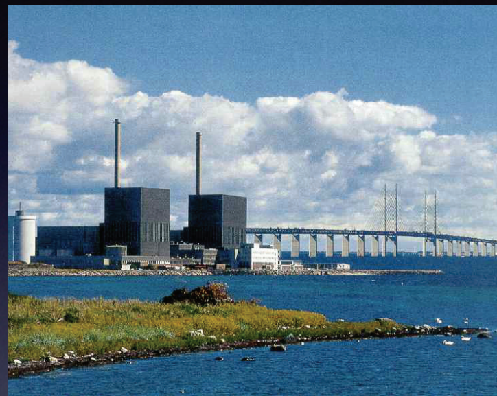
閉鎖されたバーセベック1、2号機
