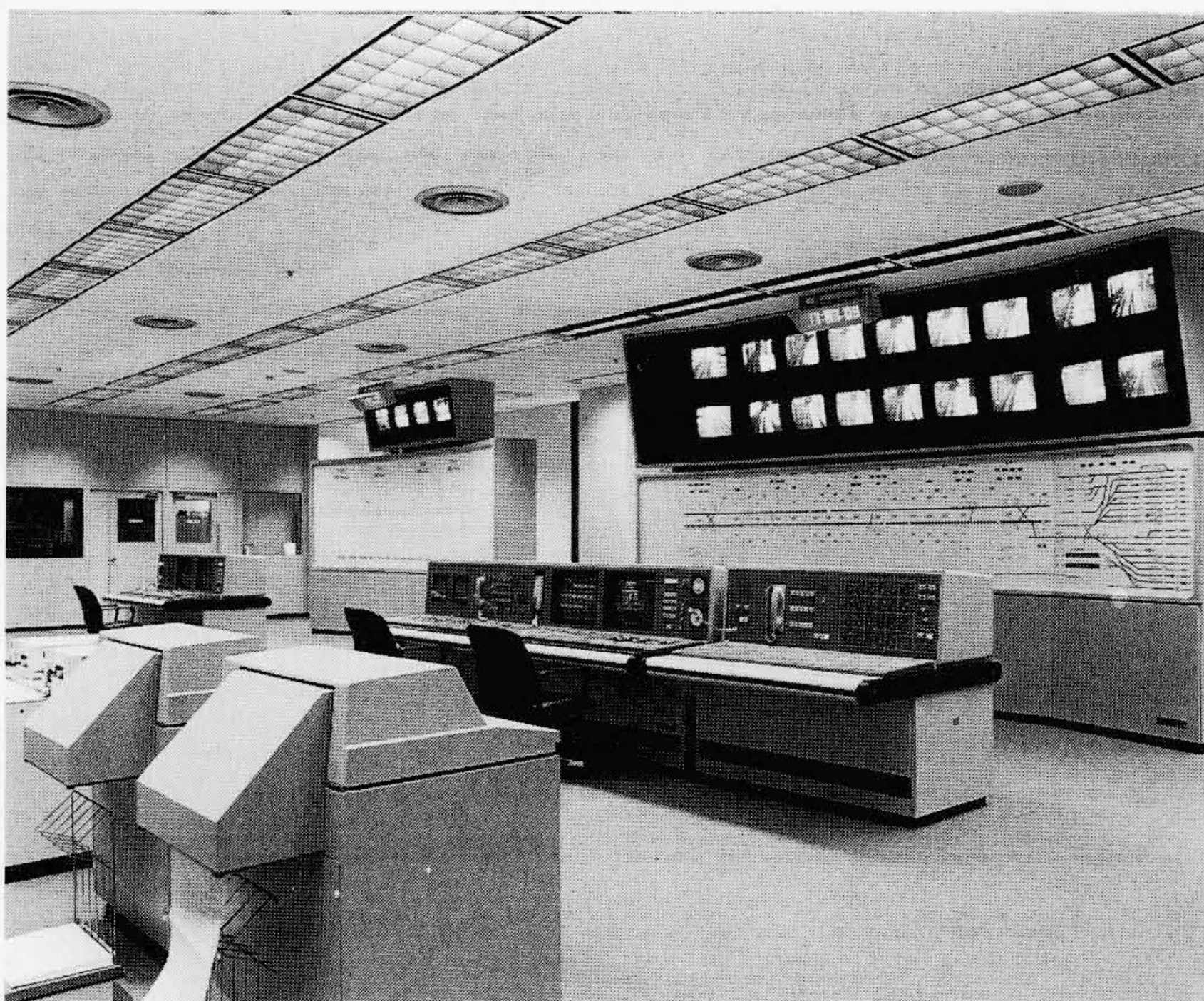
図3 総合指令センタ 右側が運行管理の、左側が設備管理の指令設備である。
