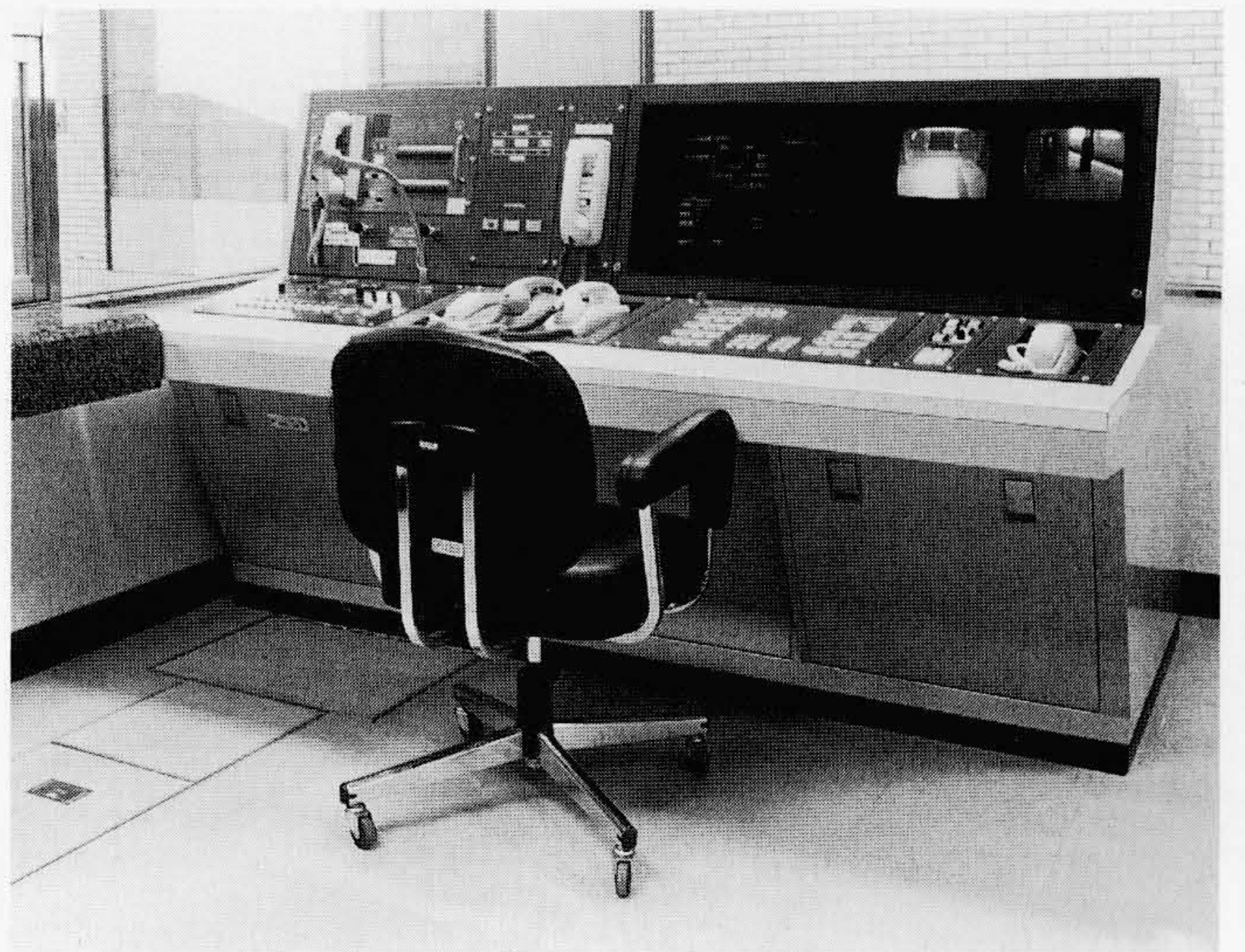
図5 駅管理制御卓 いろいろな制御がこの卓で一元的に行える。
