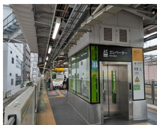
エレベーター
