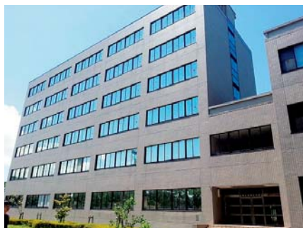
理工学部6号館
