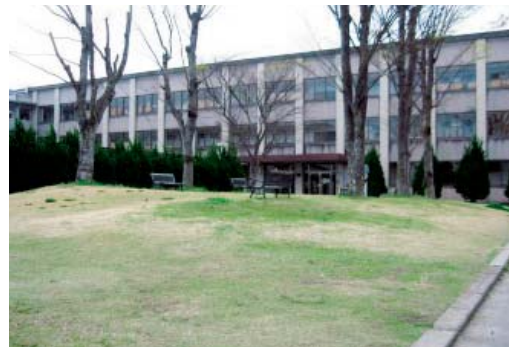
経済学部本館（現在の1号館：改修前）
