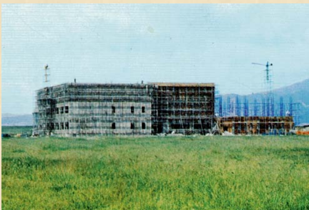
建設中の医大(昭和51年)
