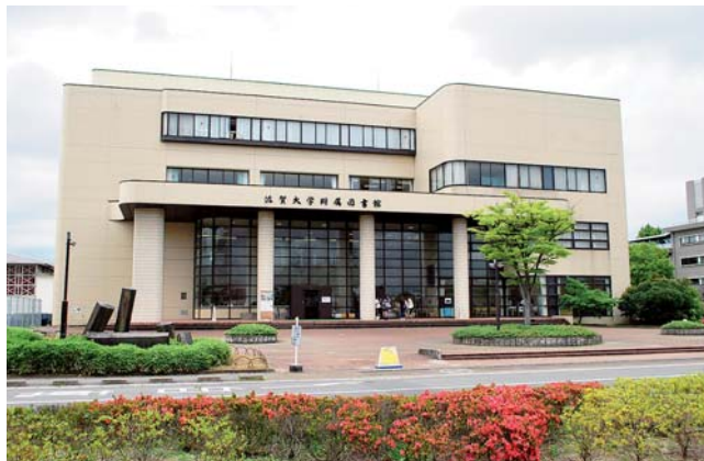
現在の附属図書館（本館）
