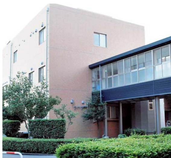
改修された動物実験施設（生物資源開発部門・鍋島地区）
