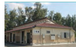
小規模校区に建設した町営住宅
