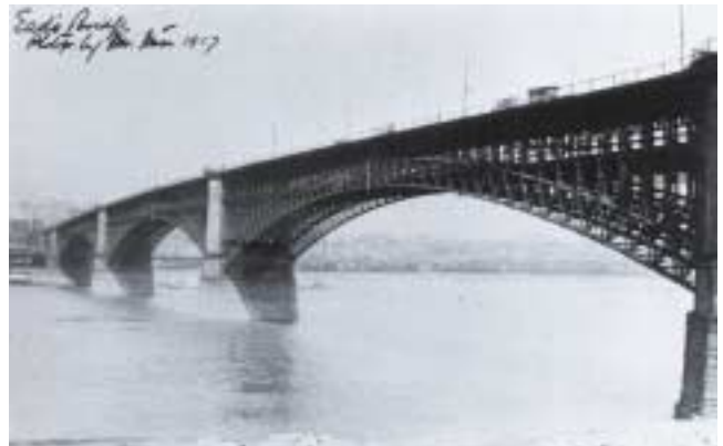
写真-3 イース橋 左上に自筆書込みがある。(「廣井勇の世界」より)
