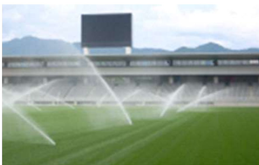
ハーフタイム中にも散水ができ、夏場に涼感をもたらす一斉自動散水システム
