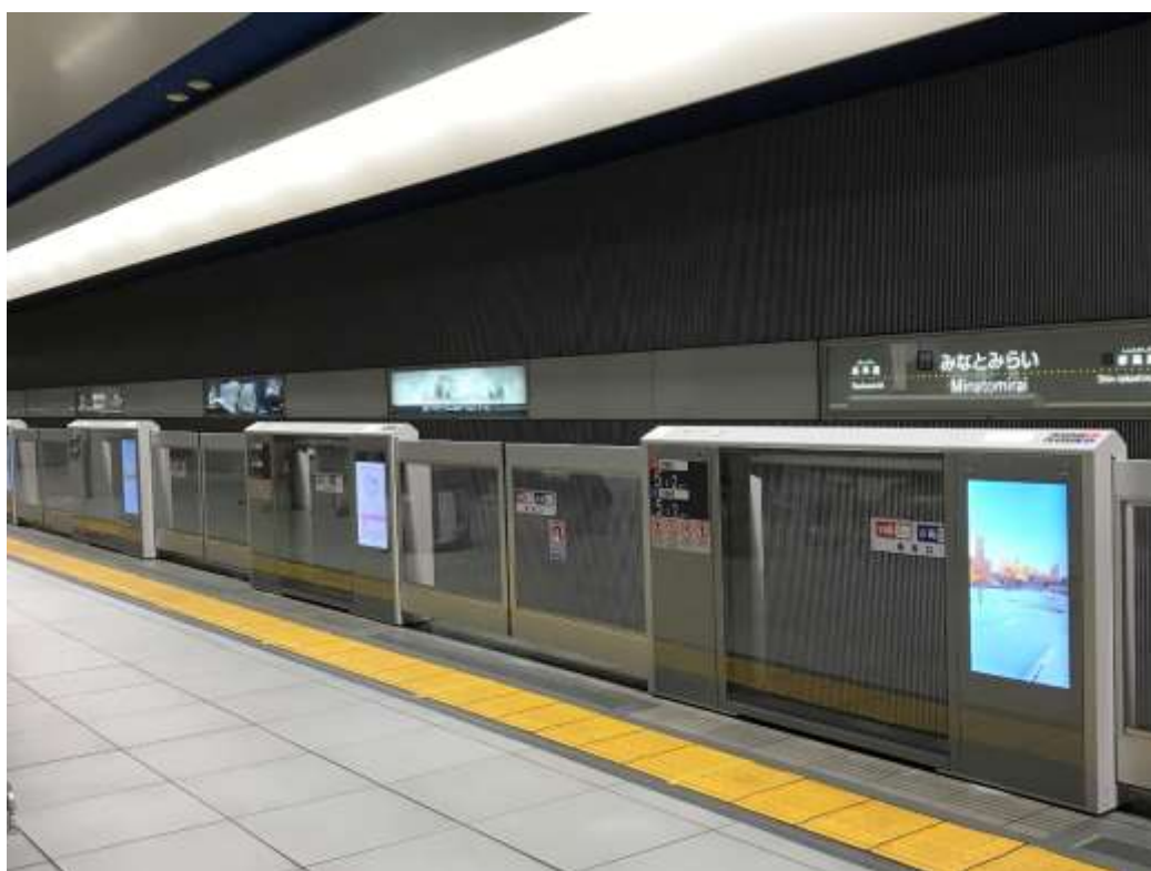
みなとみらい駅可動式ホーム柵整備状況
