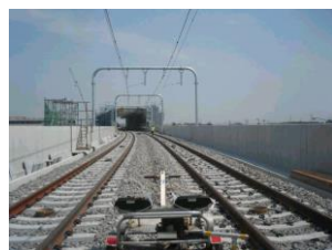
桜井駅付近高架化工事の様子
