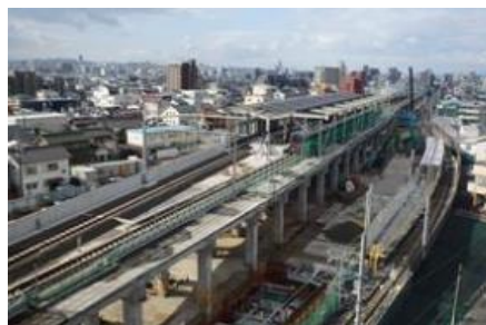
喜多山駅付近の高架化工事
