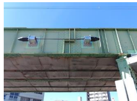
桁連結による落橋防止
