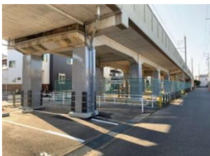
高架橋の耐震補強
