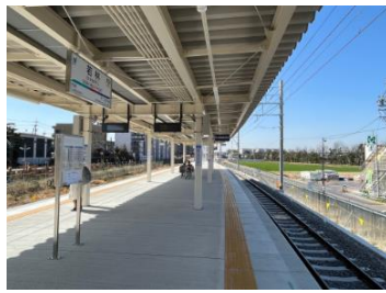
若林駅仮線ホーム
