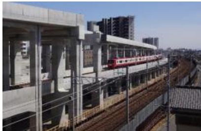
名古屋本線上り線（豊橋方面） 高架後の知立駅付近
