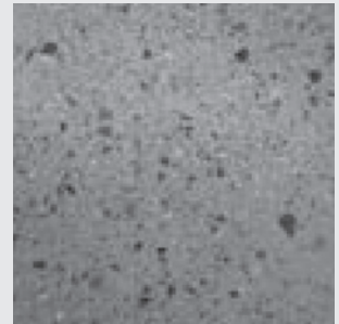
モルタルの断面
