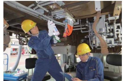
改造工事の様子
