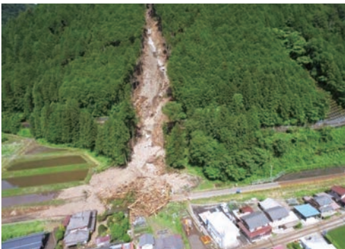
JR高山本線の被災状況（下呂市萩原町上呂市内） < 出典：平成30年7月豪雨による被害概要（6月29日からの大雨による被害）（岐阜県）>
