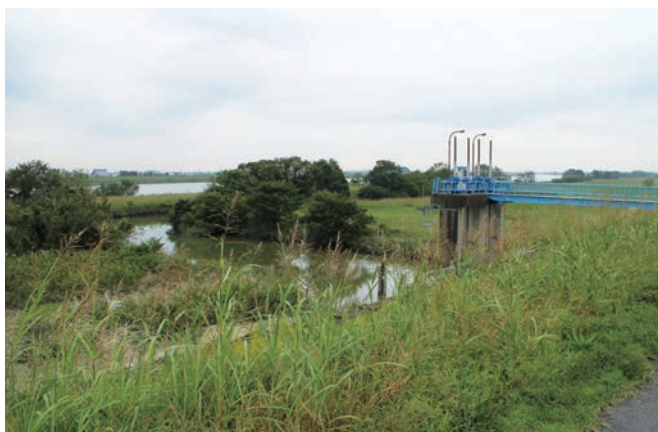
南郷排水機場から見た揖斐川
