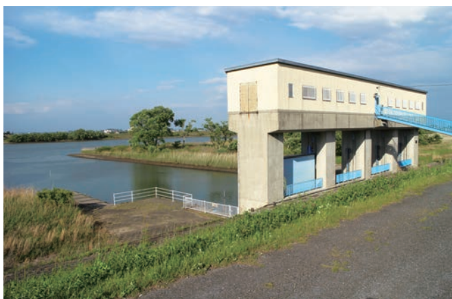
揖斐川河岸に造られた勢濃排水樋門
