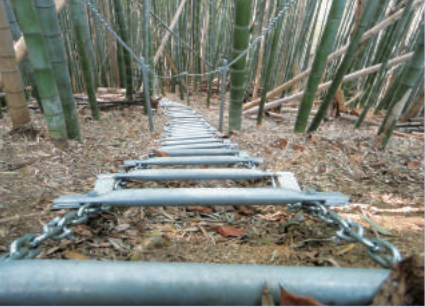
山の斜面に敷設された「くさり階段」。設置の簡易さに比べ、その救難対応への効果はきわめて高い。
