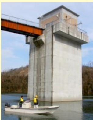
殿ダムの取水塔
