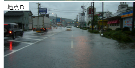
▲地点B～D: 豪雨(H18.7)による路面冠水状況 —国道3号 阿久根市多田～薩摩川内市上川内町付近—
