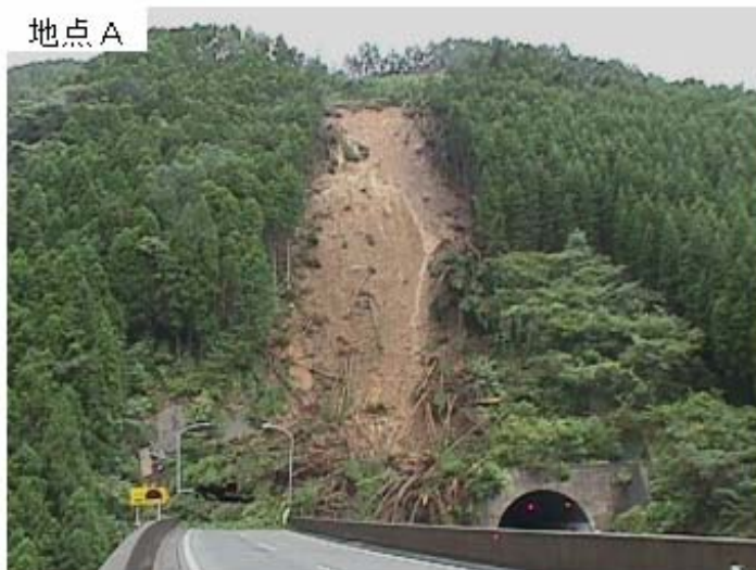
▲地点A: 台風18号(H11.9)による被災状況 —九州縦貫自動車道 登俣トンネル—
