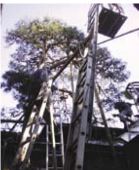
洋間の屋根に足場を掛け
