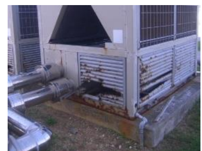
空調設備の更新
