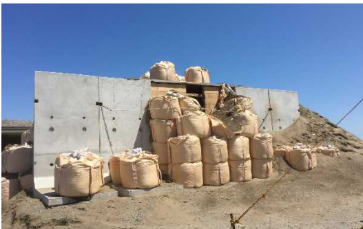
写真1 仮設試験設備例(L15弾薬の改善)
