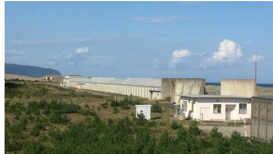
写真2 覆道式ドーム射場外観
