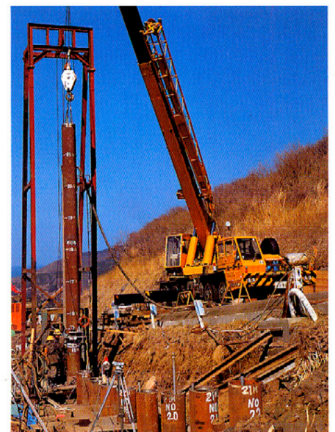
Gパイルの建込作業
