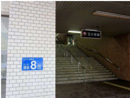
【設置例：室蘭線苫小牧駅】
