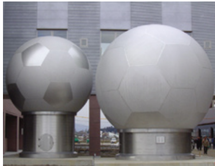
サッカーボール型受水槽
